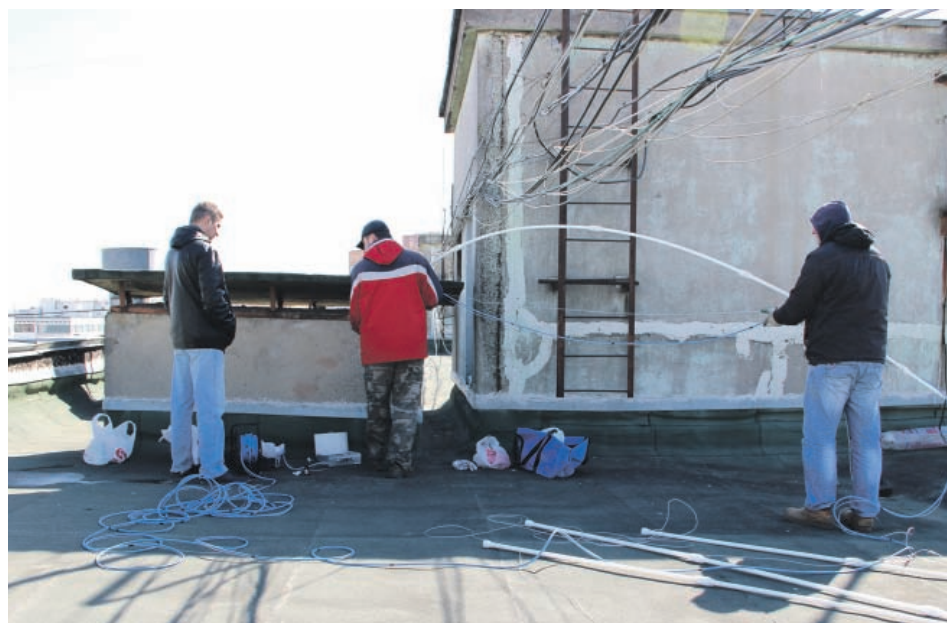
При помощи специального оборудования элемент, ограничивающий водоотведение, спускают в общедомовой канализационный стояк
